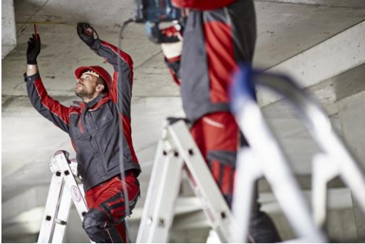
MEWA Dynamic: werkkleding op de bouwwerf
