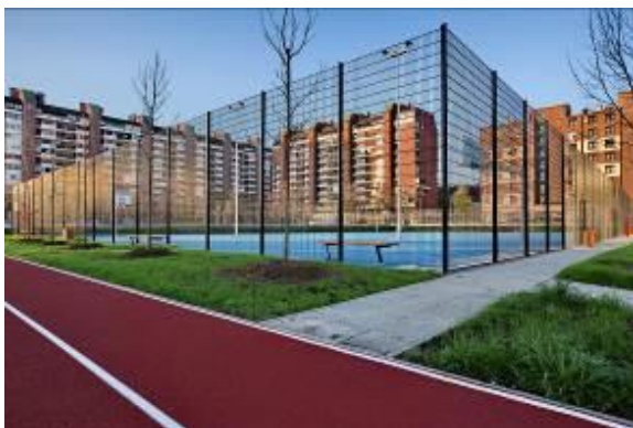
Des panneaux Nylofor 2D Super ont été placés tout autour des terrains de sport (Photo : Betafence)
