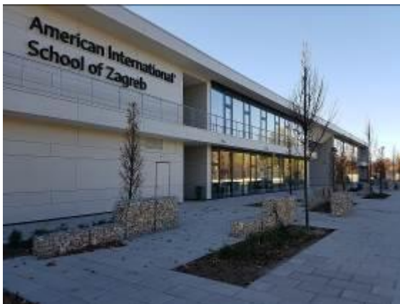
Les gabions se marient naturellement à la modernité du bâtiment (Photo : Betafence)
