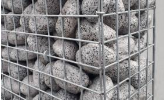
Detail van een Gabion Stonewall
