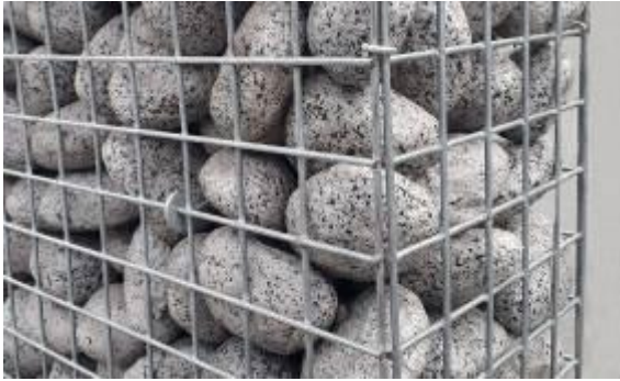
Détails d'un Gabion Stonewall
